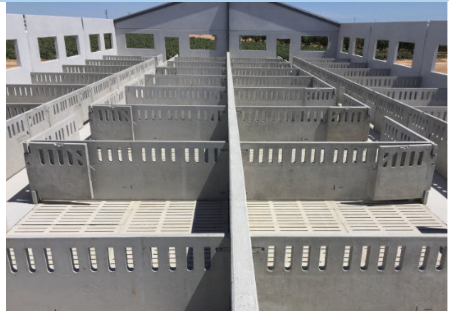
Puertas de hormigón cierre pasador
